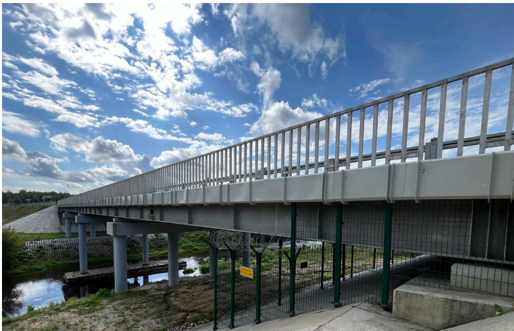
Первый в РФ автодорожный мост с пролетными строениями из алюминиевых сплавов через р. Линда на км 5+351 автомобильной дороги «Толоконцево-Могильцы» в г.о.г. Бор Нижегородской области
