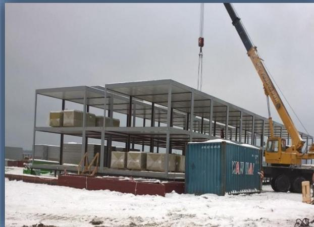
Собранный каркас здания из блок-модулей
