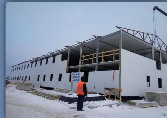
Обшивка каркаса трехслойными сэндвич-панелями
