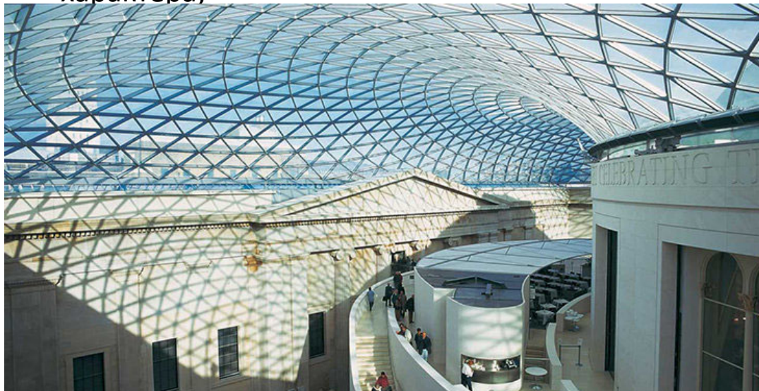
Дворик Британского музея, перекрытый сетчатой оболочкой
