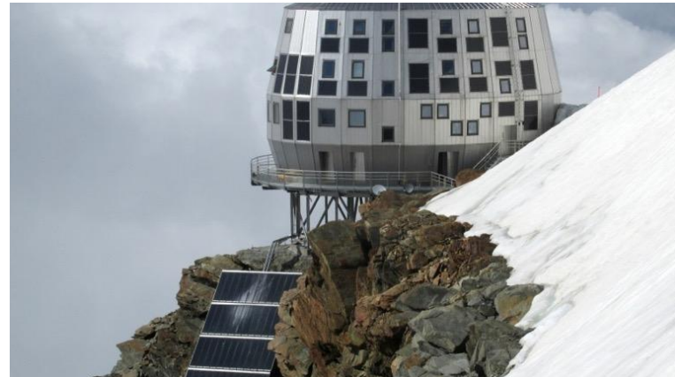
Mountain Hut «del Goûter» Mont Blanc (F)
