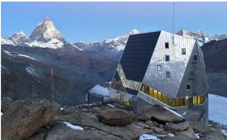
Mountain Hut «Hutte» Monte Rosa (CH)
