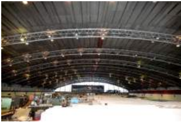
Покрытие Главного зала ускорителя в Протвино (1961 г.), пролет 90 м.
