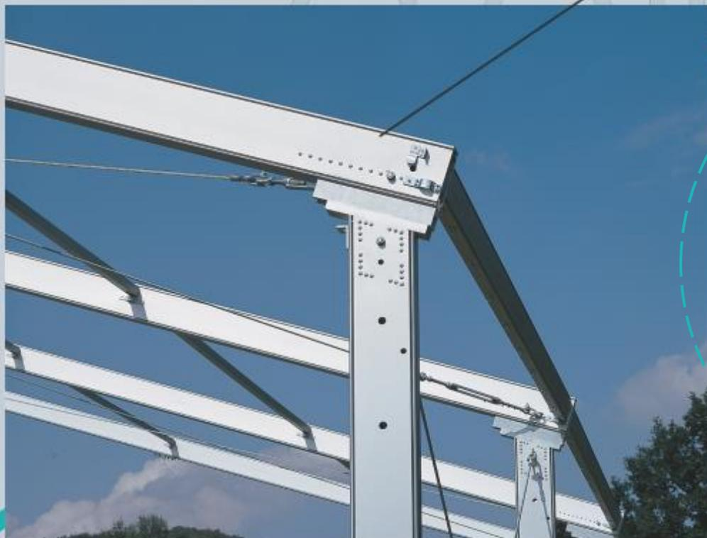
Все основные элементы каркаса конструкций АЛЮМС изготавливаются из алюминия.
