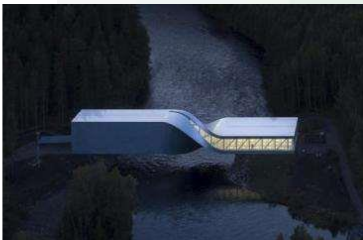
Мост в Норвегии через реку Рандсельва
