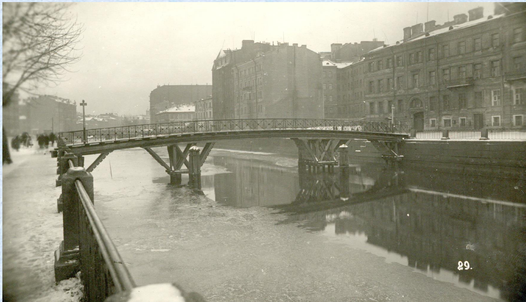
Коломенский мост через канал Грибоедова в Ленинграде (до реконструкции). XX в.
