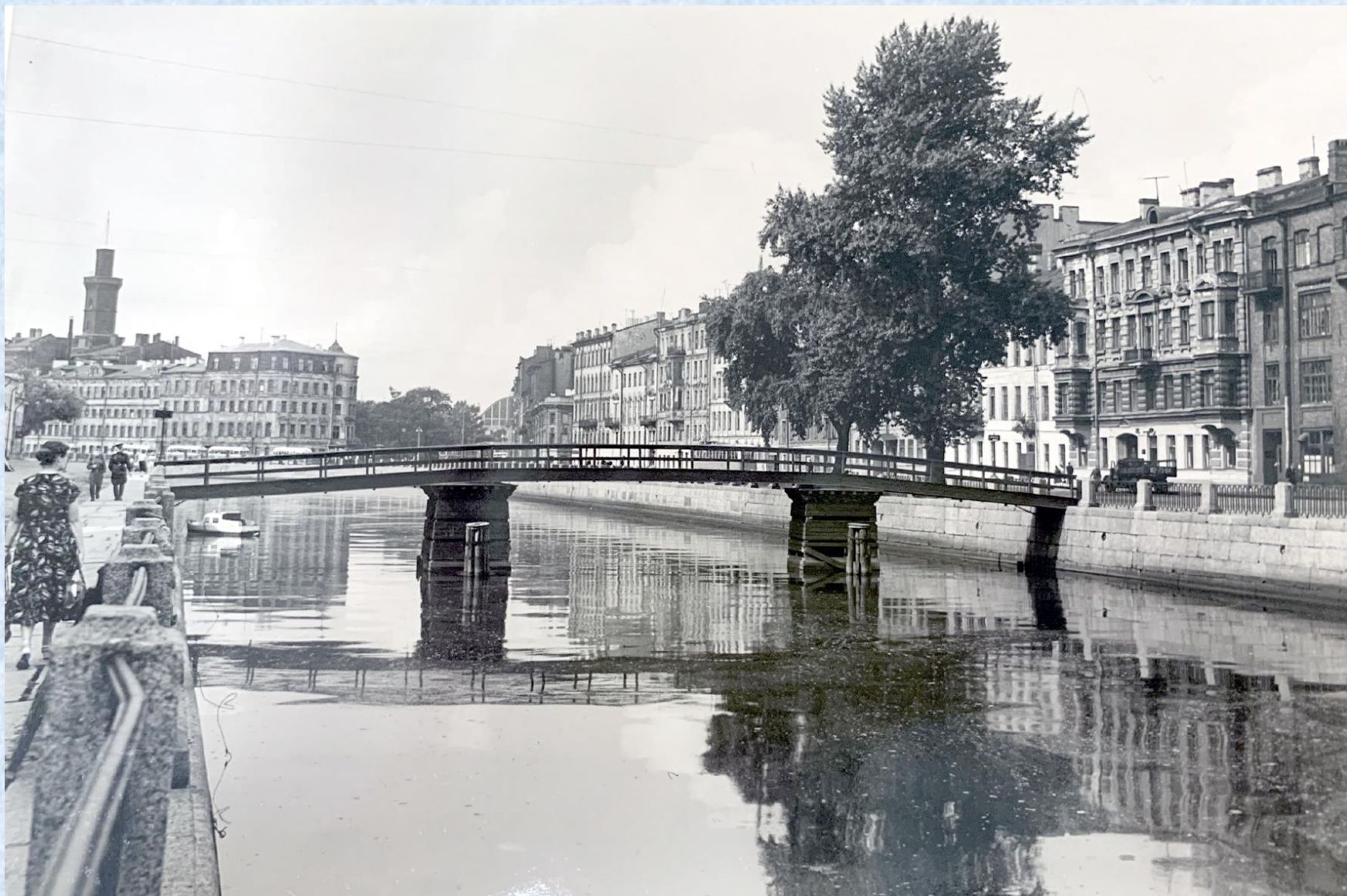
Коломенский мост через канал Грибоедова в Ленинграде после ремонта. 1957 г.
