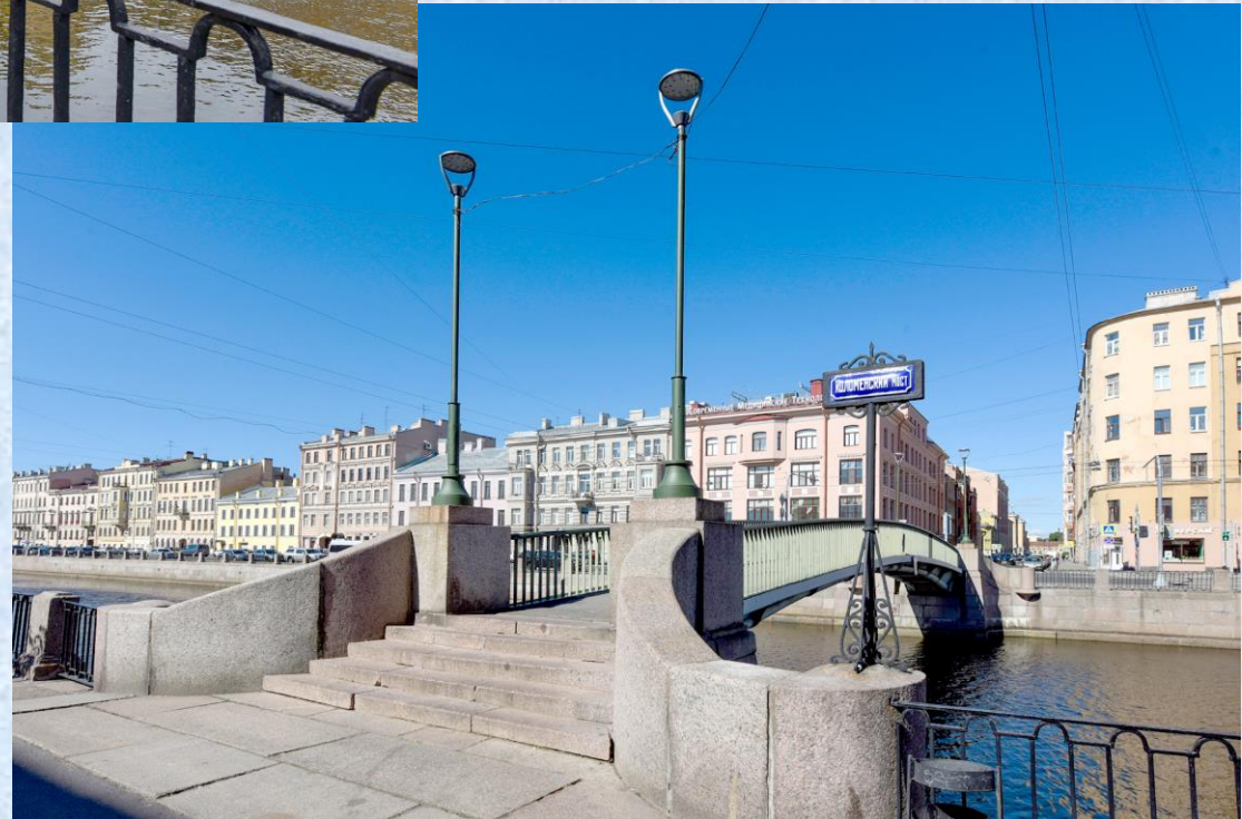
Коломенский мост через канал Грибоедова в Санкт-Петербурге. 2021 г.
