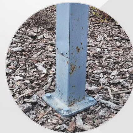
Металлическая опора с покраской Срок службы защитного покрытия 2-5 лет
