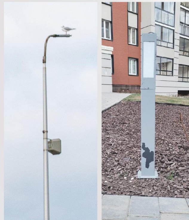
Металлическая опора с покраской Срок службы защитного покрытия 2-5 лет
