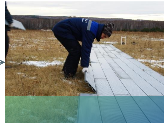
ПЛИТЫ СОБИРАЮТСЯ ВРУЧНУЮ БЕЗ КАКОЙ-ЛИБО ТЯЖЕЛОЙ СПЕЦ. ТЕХНИКИ
