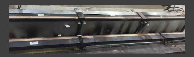
Узел пересечения, крепящийся к бетонному ригелю, размером (4400х450х250) мм, с помощью металлических кронштейнов, каждый из которых представляет собой конструкцию из четырех металлических пластин, толщиной по 5 мм
