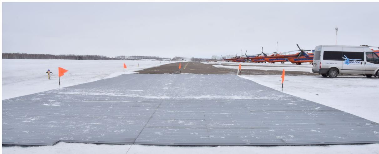
Сравните это с весом двухметровой алюминиевой ламели, выполненной из сплава 6082, который составляет всего 11 кг в основной версии и 6,4 кг в облегченной – для площадки SA02. Комплект такой площадки к месту ее установки доставляет один вертолет. Затем бригада из четверых монтажников разворачивает площадку за шесть часов, не используя для этого тяжелую технику и специальное оборудование. Отсюда и название – «Формула 4х6»: четверо монтажников за шесть часов.
