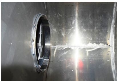
Сварка элементов автоцистерны
