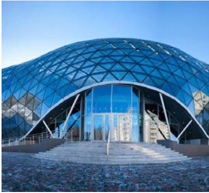
Биотехнопарк в Кольцово (Новосибирская область)
