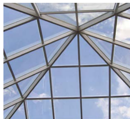
Основной вес в светопрозрачных конструкциях приходится не на алюминиевый каркас, а на стекло или стеклопакеты, различных габаритов и структуры
