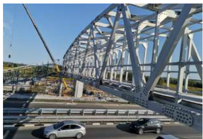
В Туле завершают строительство первого в ЦФО надземного пешеходного моста из алюминия
