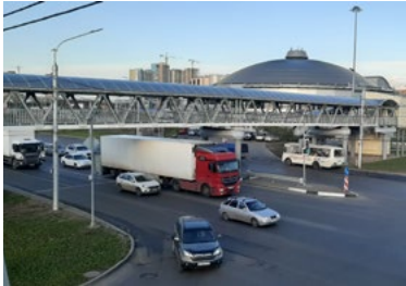
Мост из алюминиевых сплавов в Красноярске
