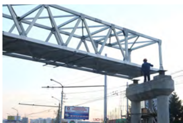
Этап монтажа моста из алюминия в Красноярске
