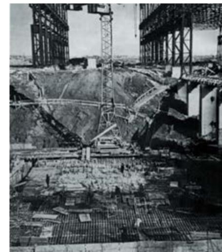
Строительство здания цеха, где и сейчас располагается один из крупнейших в мире вертикальных прессов усилием 75 тысяч тс, 1959 год. Высота пролета – более 30 метров, заглубление фундамента под пресс – более 20 метров
