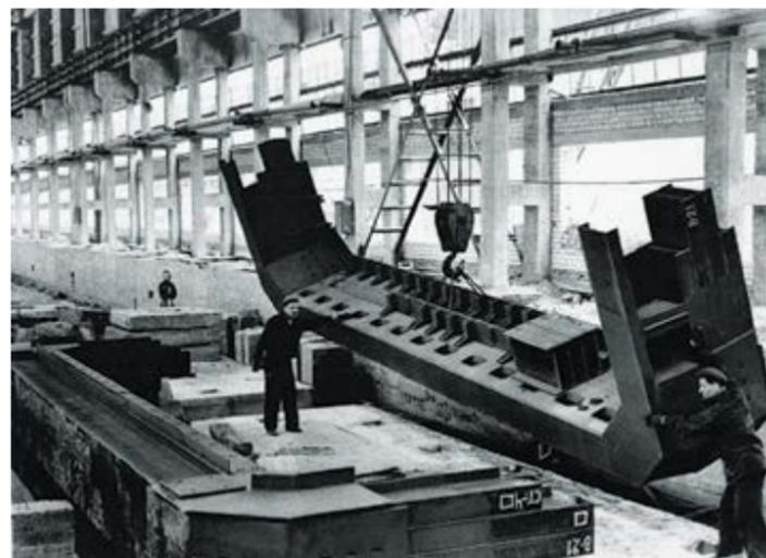
Транспортировка мостовым краном секции катодного кожуха электролизера на фундамент, 1958 год
