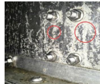
Гальваническая коррозия
