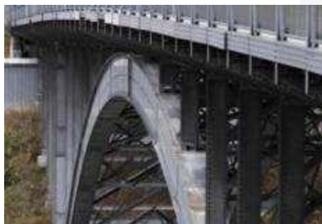
世界初の100%アルミニウム橋、1949年にカナダのサグネイ川の上に建設された
