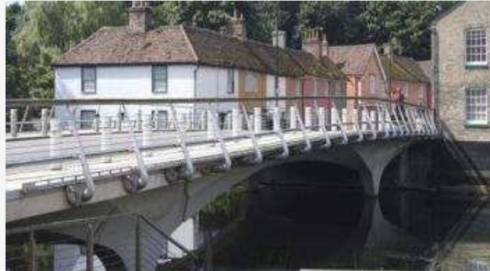
Ballingdon Bridge、イギリス (2003)
