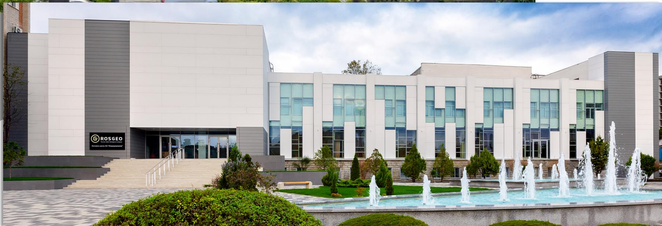
Реставрация фасада конгресс-центра АО «Южморгеология», г. Геленджик
