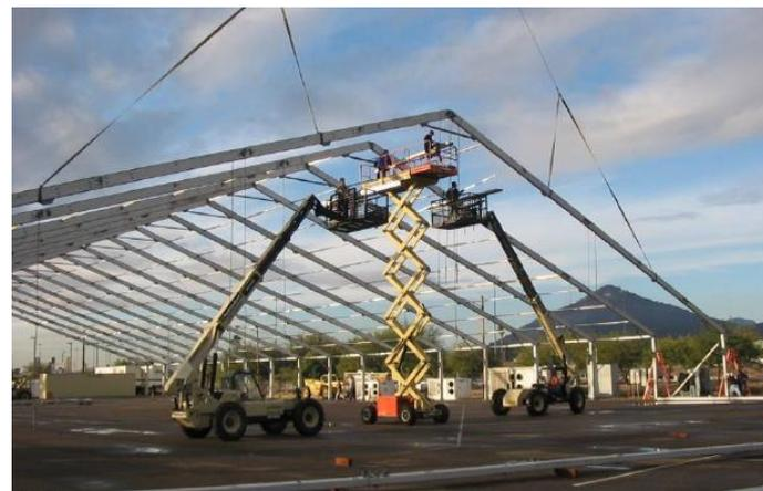
Каркасные конструкции. Ширина безопорного пролета до 50м
