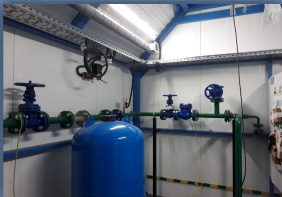
Разводка и подключение инженерных коммуникаций
