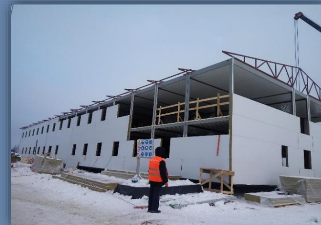
Обшивка каркаса трехслойными сэндвич-панелями
