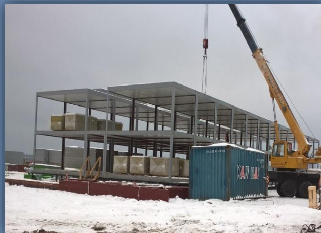
Собранный каркас здания из блок-модулей
