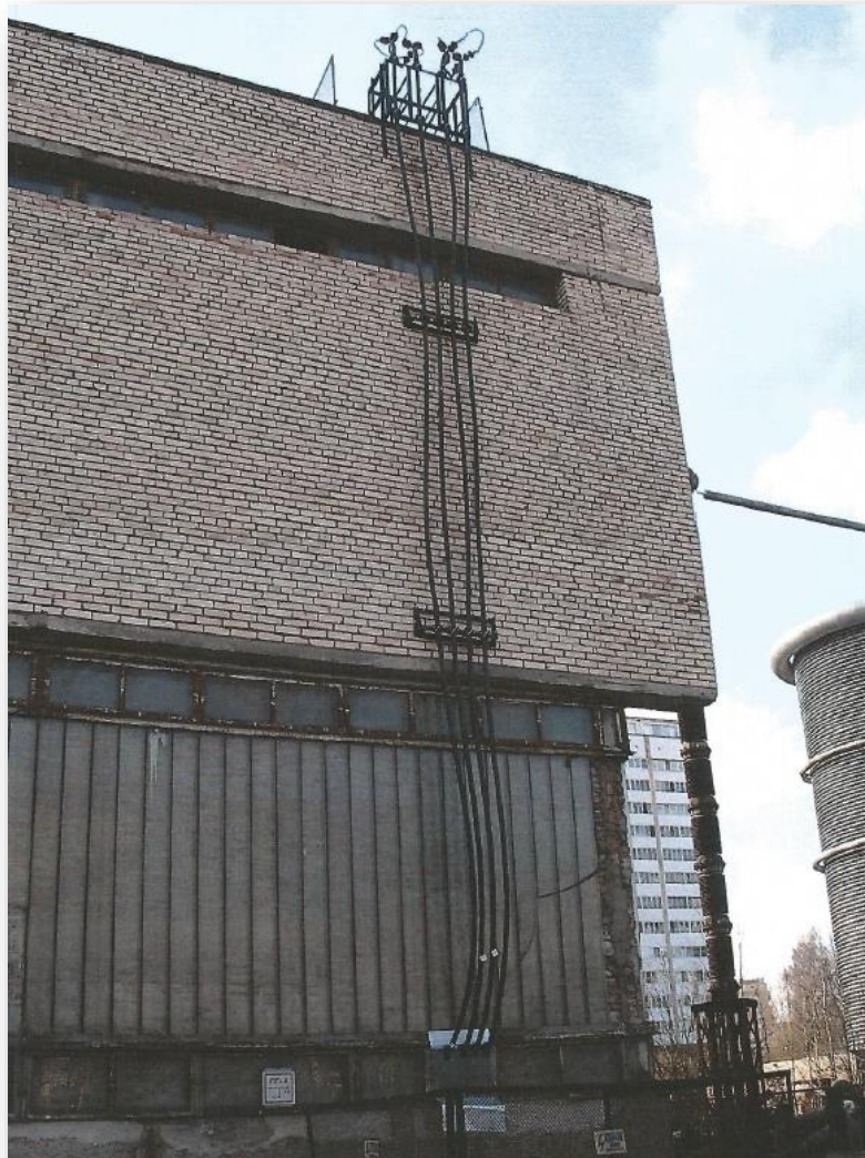
Вертикальная подвеска кабелей с перепадом высот 15 м
