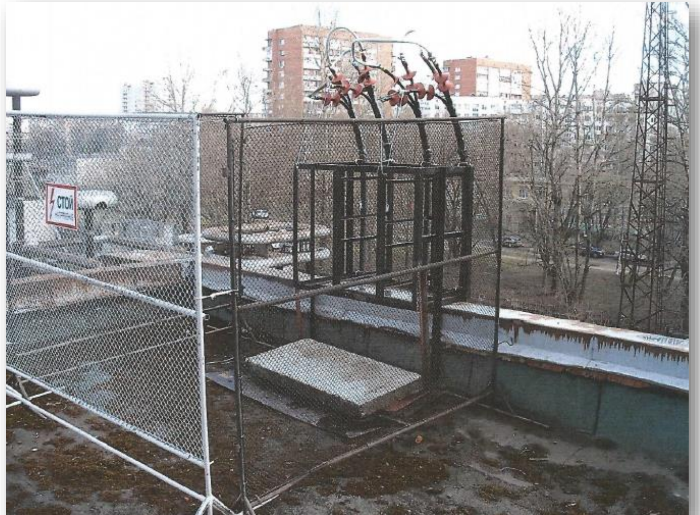
Крепление муфт на высоте 15 м
