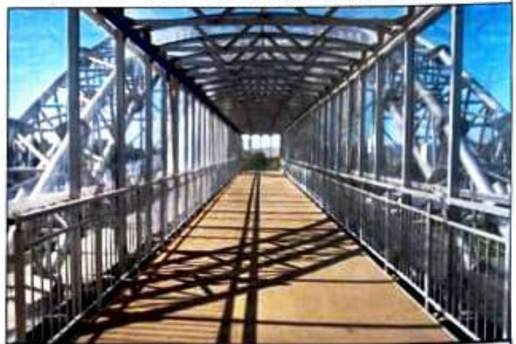
Bild 3: Brückenelemente einer aus Aluminiumhalbzeugen gefertigten Brücke in Nizhniy Novgorod; Foto mit freundlicher Genehmigung von Aluminium Association (Russland)
